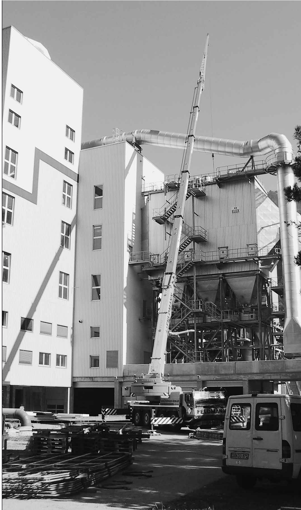
◀ Mit einem mobilen Grosskran werden die Elemente des Elektrofilter 1 gewechselt.
