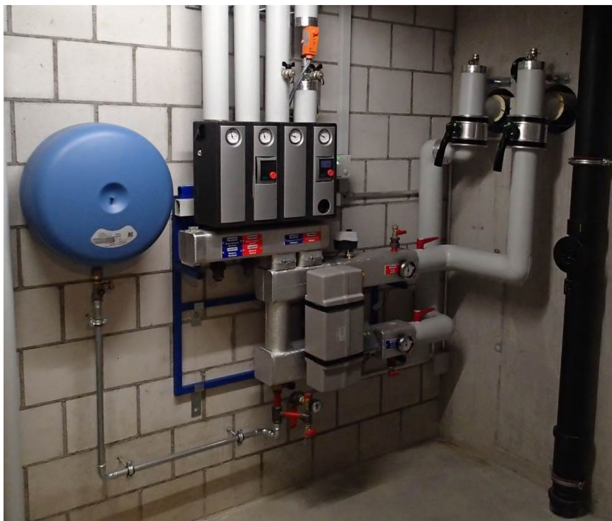
Abbildung 2: Ansicht Fernwärmestation
