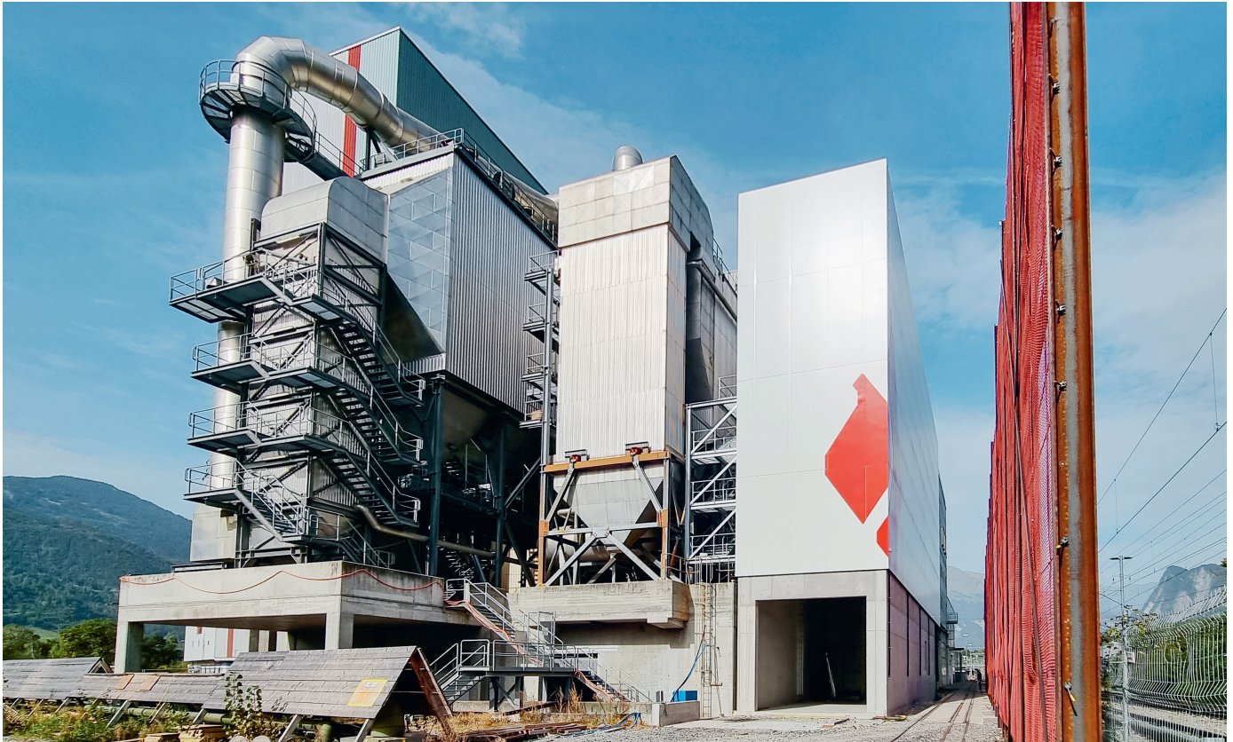
Die GEVAG wird um die neue Schlackenlogistik ergänzt (Gebäudeteil rechts).
