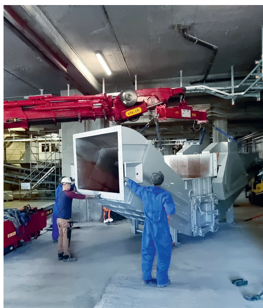
Koordinierte Montagearbeiten beim Umbau der bestehenden Schlackenlogistik.
